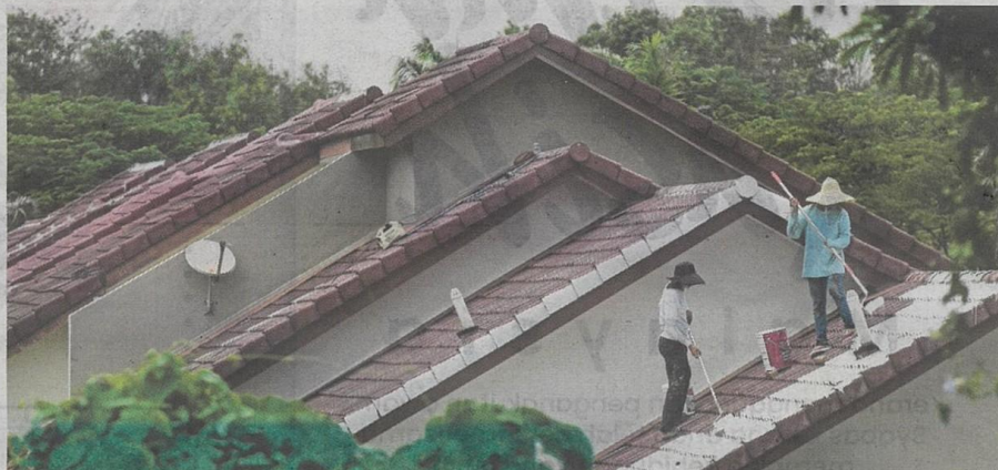
Kerja membaik pulih rumah yang terjejas akibat insiden letupan paip gas di Putra Heights giat dijalankan.
