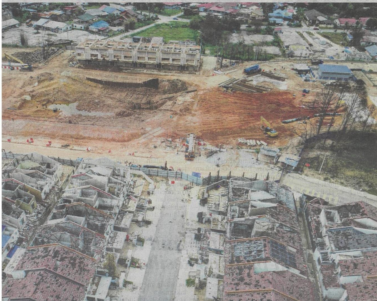
paip gas bawah tanah milik Petronas di Putra Heights di Subang Jaya pada 1 April lalu.
